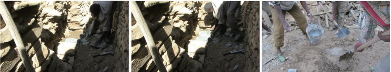
③壁面の構築：（左、中央：基礎には大きな石材が使われるのに対し（②）、壁面には小さな石材が使われる、右：両側面の石材が噛み合うように並べられる）
