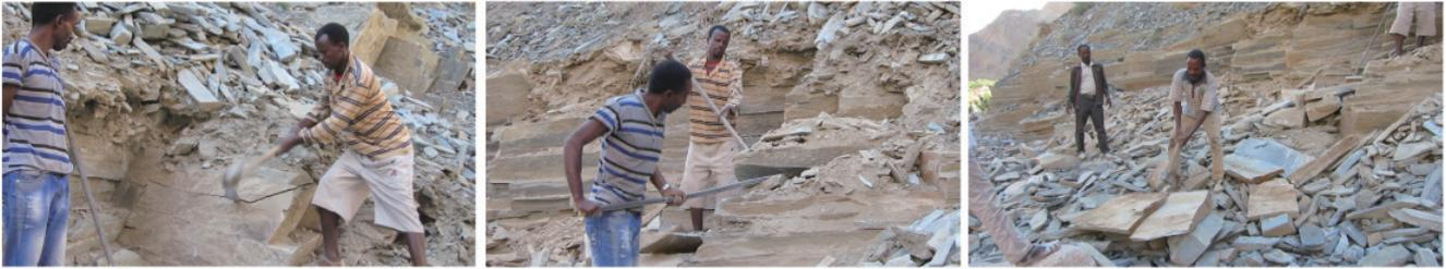
②基礎の構築（左：石材を適合するサイズに削る、中央：石材を所定の位置にはめる、左：目地は土と水から作られる）
