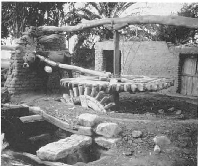
③ 木製水車、水牛によって水車を回転させ、農地の給水路に送る。下エジプト。
